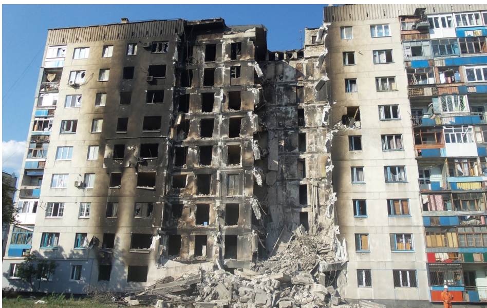
Рис. 5. Фото частично разрушенного и сгоревшего панельного девятиэтажного дома, г. Донецк [12]
